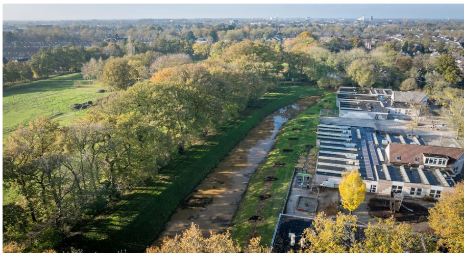
Bestaande sloot/watergang met talud
