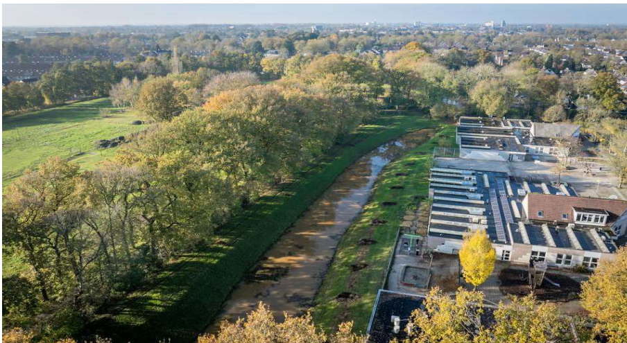
Bestaande sloot/watergang met talud
