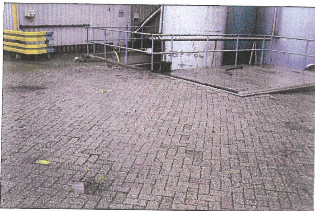
Figuur 6.5 Ter plaatse van verdachte locatie B en D
