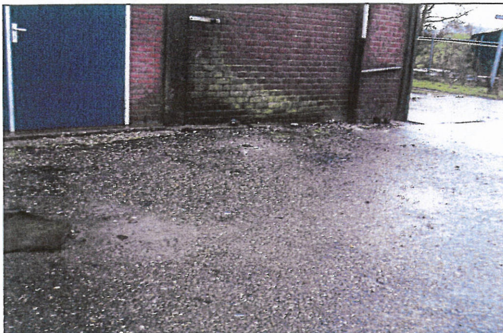
Figuur 6.3 Ter plaatse van ondergrondse dieseltank (verdachte locatie C)
