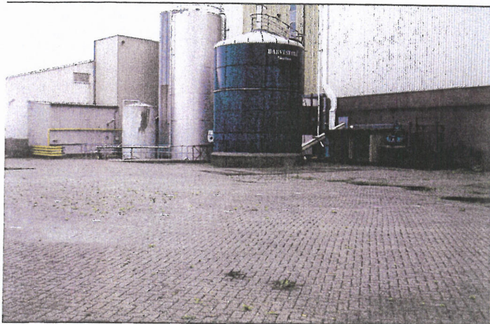
Figuur 6.1 Fabriek / silo
